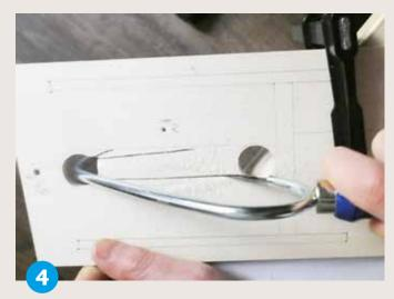
Säge die Aussparung mit der Feinsäge aus.
