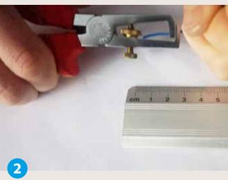
**Entferne** ca. 15 mm der Isolierung mit der Abisolierzange jeweils an beiden Enden.
